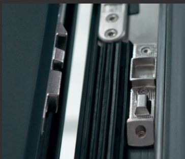
Антизломні болти - це додаткове устаткування, яке покращує антизломні характеристики дверей. Вони встановлюються з боку петель на дверному полотні та на коробці. Залежно від необхідного ступеню безпеки можна застосовувати різну кількість наборів для одного полотна.
